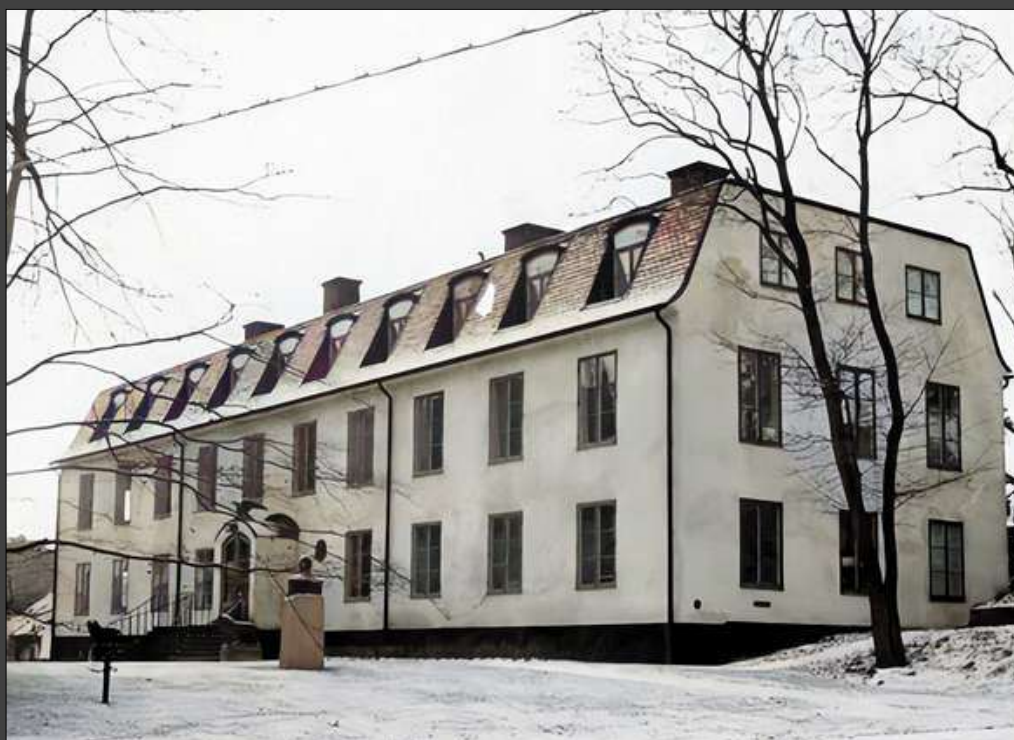
Manbyggnaden på Kallhälls gård byggdes om till kontor på 1940- talet.
