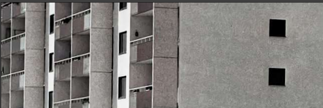
Det här är Skärholmen men det kunde vara Kallhäll. Betongelement monterade rätvinkligt.
