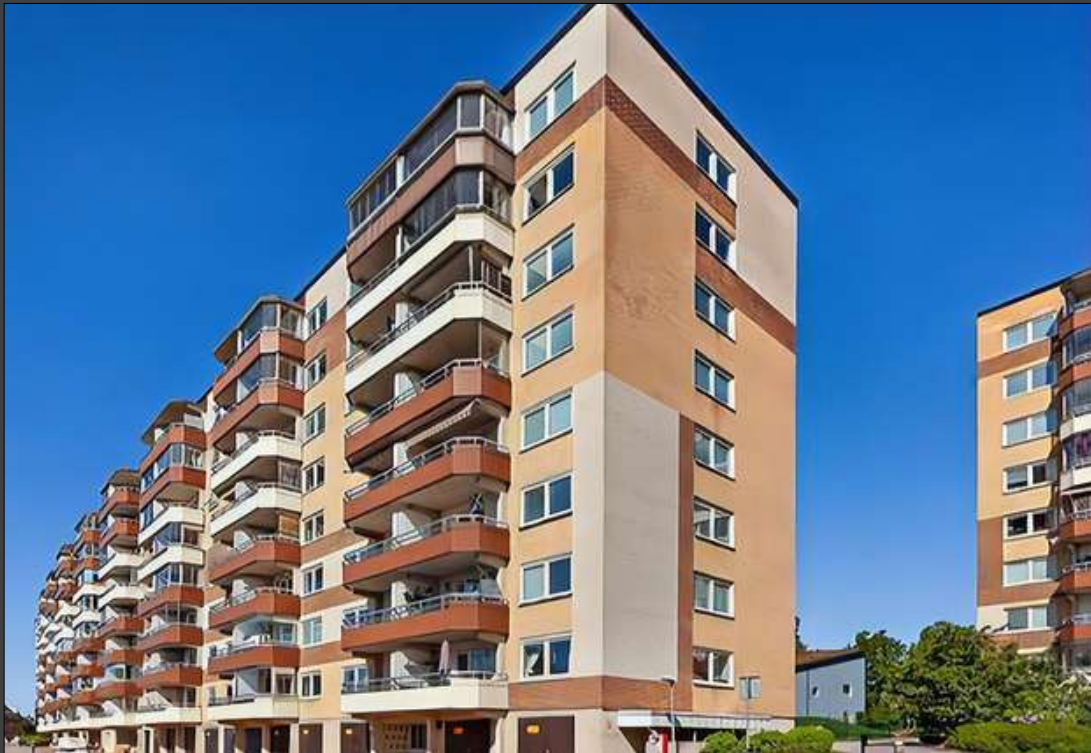
Är detta Kopparvägen i Kallhäll? Ja, min sju. Husen är inte så grå som på 1960- talet men de är – trots ombyggda, mastiga balkonger – lika fyrkantiga, lika höga och lika fula (enligt min uppfattning).
