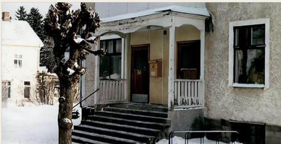
Poststation, med brevlåda och fem platser för cykelparkering.
