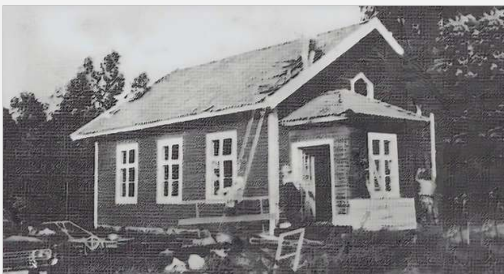
Utvändig reparation år 1979.
